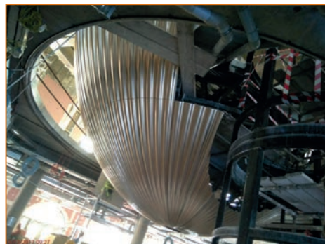
Fig. 2 Dal punto di vista architettonico, il progetto è stato reso ancora più difficile dal fatto che la struttura dell'uovo Fabergé doveva adattarsi al design dell'edificio e al layout del nuovo hotel in costruzione. Le sezioni esterne di rivestimento in vetroresina, prodotte utilizzando la resina Crestapol® 1212 con 170 phr ATH, sono state le parti più impegnative da stampare per Look Composites, ovvero forme tridimensionali ondulate, a doppia curva, che dovevano combaciare perfettamente
